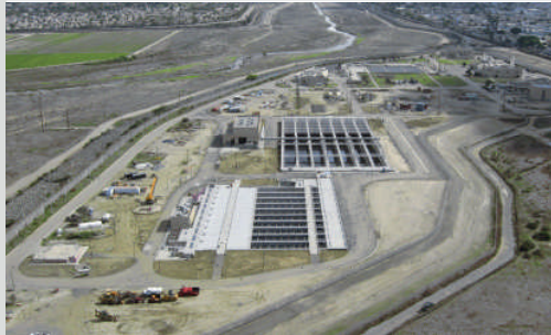
Das neue 2.000 Kilowatt-Aggregat verdoppelt den verfügbaren Notstrom der Kläranlage.
